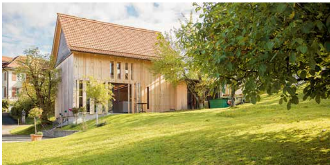
Die 200-jährige Scheune, in der ein Loft entstanden ist.
